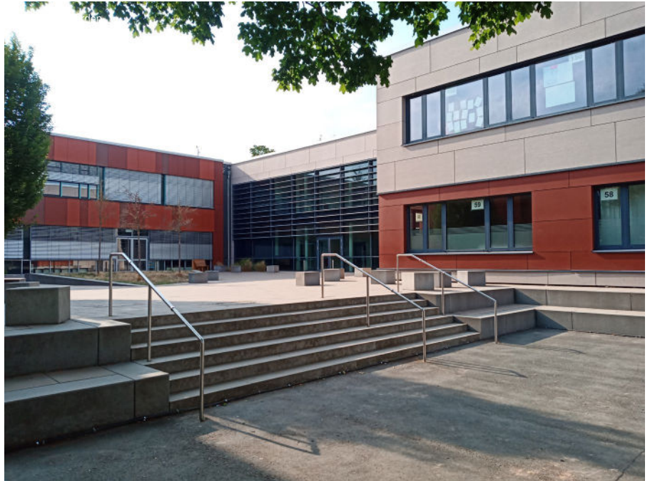
Grund- und Oberschule der Stadt Gehrden. Primary and Secondary School of the Town of Gehrden.
