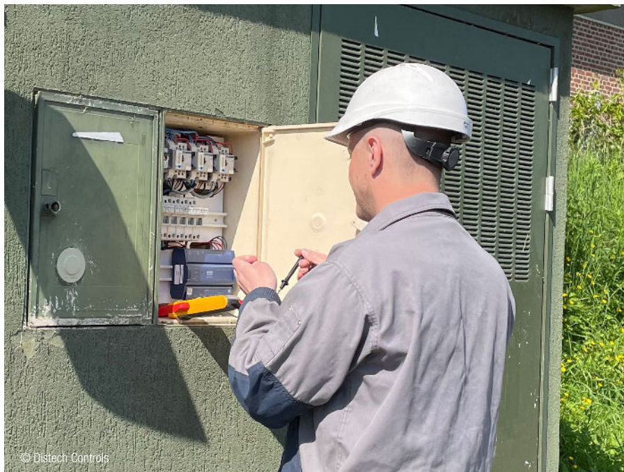
USEDAROC-Schaltschrankinstallation. USEDAROC electrical panel installation.
