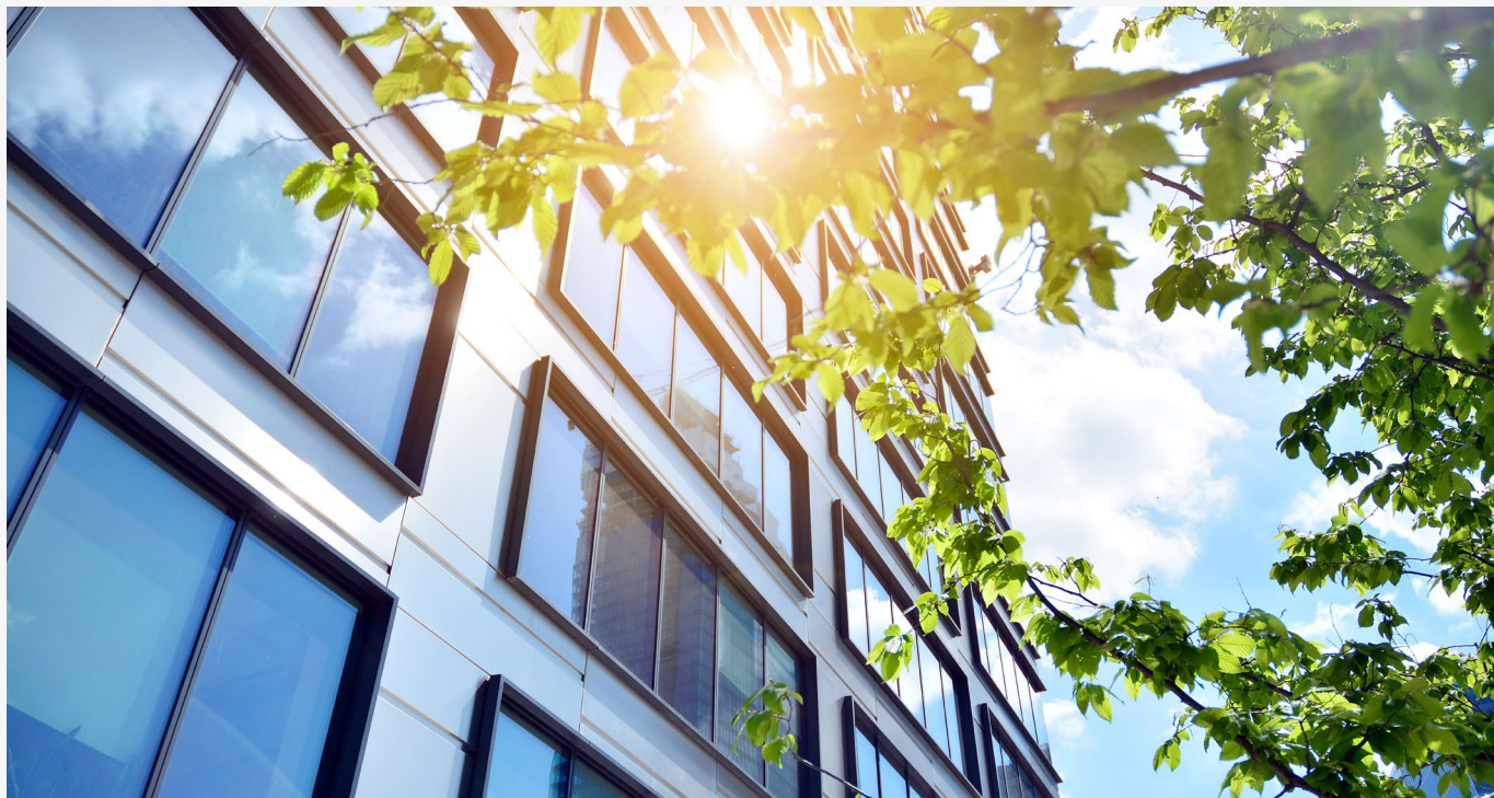
Zur Erreichung des Automatisierungsgrades „B oder besser“ ist in NWG ein automatisch betriebener Sonnen- bzw. Blendschutz erforderlich. To achieve automation level “B or better”, an automatically operated sun or glare protection is required in NRB.
